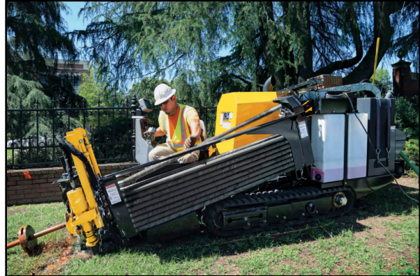
Photo 2-4. Mini HDD Rig.
